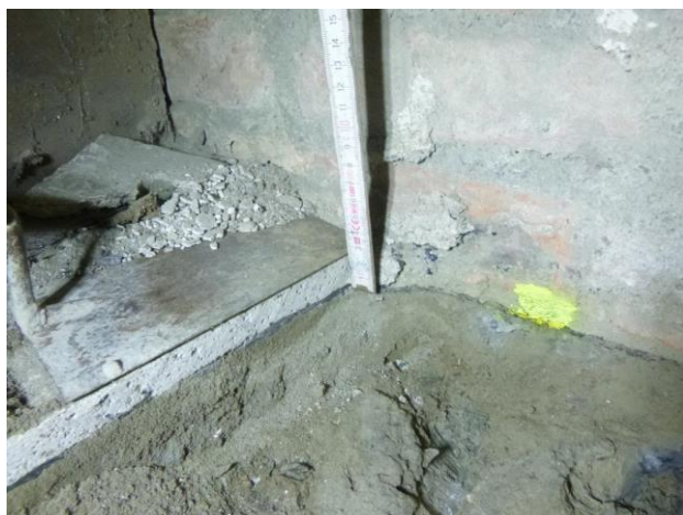
Měření hloubky základové spáry od podlahy ve sklepe.
